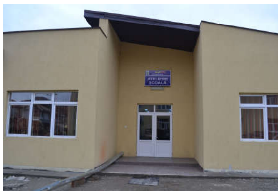
Clădirea nouă a Atelierelor școlare
